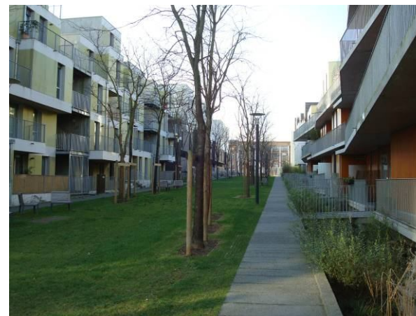
Illustration d'une courée résidentielle : espace de jeux, de détente, sans voiture, sécurisée et permettant la surveillance.
