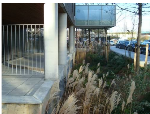
Illustration d'une noue en pied de construction
