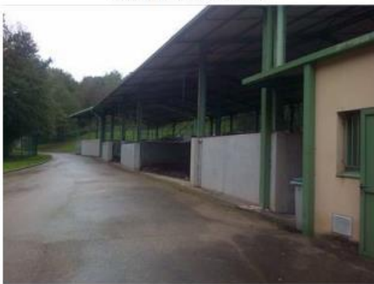
Aires de stockage des boues
