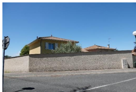
Mur récent traité à minima (enduit)
