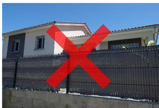
Grillage doublé de lamelles plastique
