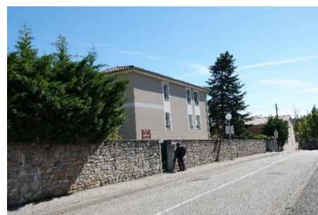
Préservation du mur ancien en pierres
