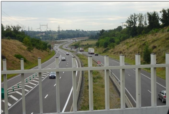
L'A89 depuis le pont qui la surplombe
