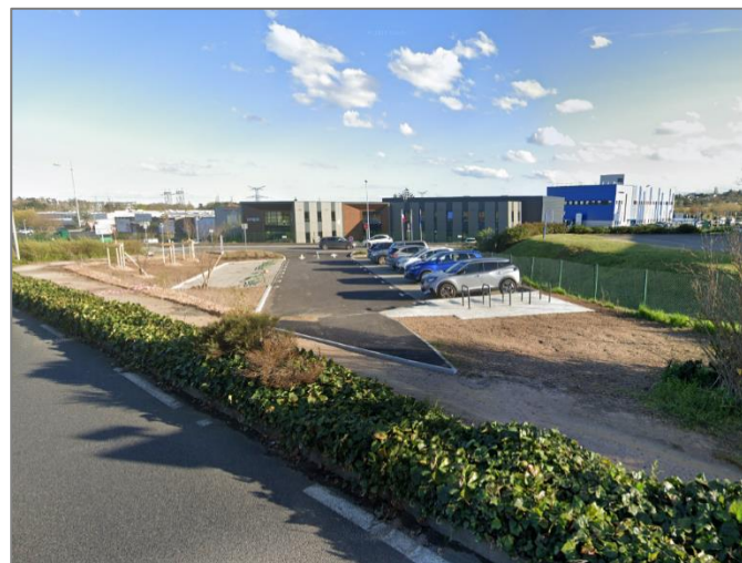
Aire de covoiturage de Lentilly-Charpenay. Crédit : Google Street View.
