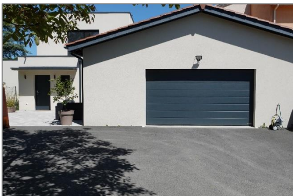
Minéralisation extrême des abords d'une maison
