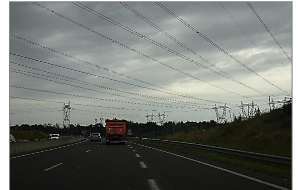
Couloir de lignes électriques depuis l'autoroute
