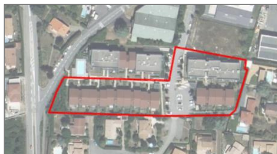
Constructions réalisées sur le secteur de La Madone
