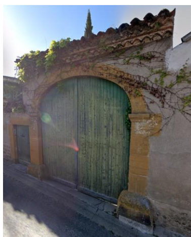
Exemple de porche et corniches à la lyonnaise
