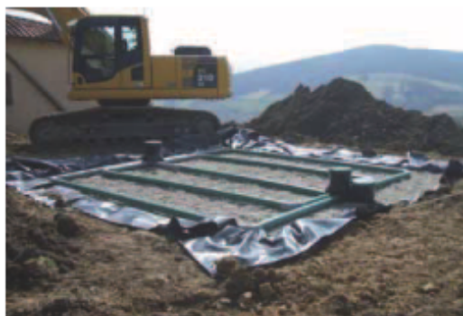
Travaux de réalisation d'un filtre à sable
