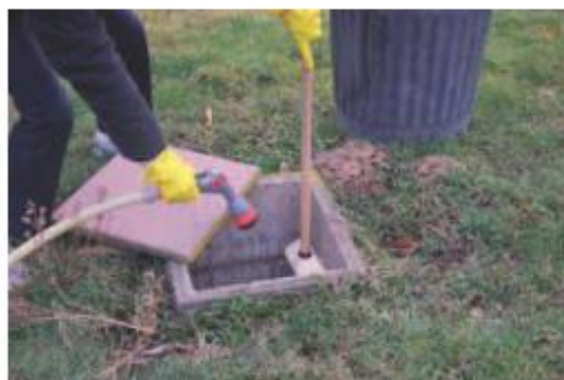
Nettoyage périodique des regards de visite.
