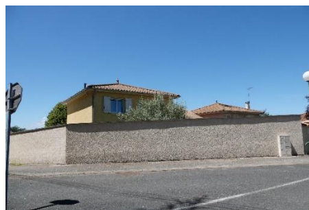
Mur récent traité à minima (enduit)
