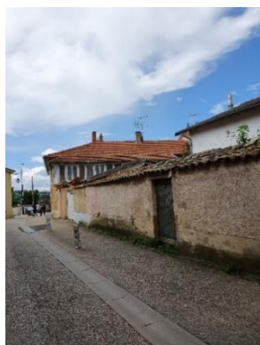
Mur traditionnel surmonté de tuiles
